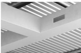
Dall'esperienza trentennale di EDILTEC nasce POLIISO AIR, un sistema per la realizzazione di canali pre-isolati per il trasporto dell'aria. Il sistema non si basa solo sui pannelli in poliuretano espanso con rivestimento in alluminio pre-isolato ma si articola anche su accessori, macchinari, utensili e know-how necessari per la costruzione e l'installazione a regola d'arte dei canali.
